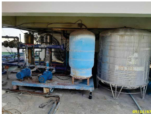
Booster Pump อาคาร A, B
